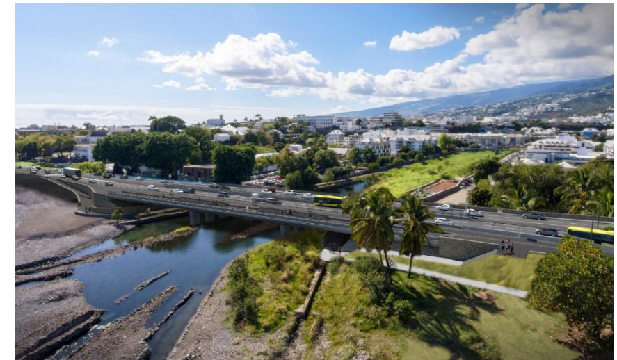
Construction d'un ouvrage de franchissement de la rivière Saint-Denis, à l'aval de l'ouvrage existant, long de 110m et large de 24m.
