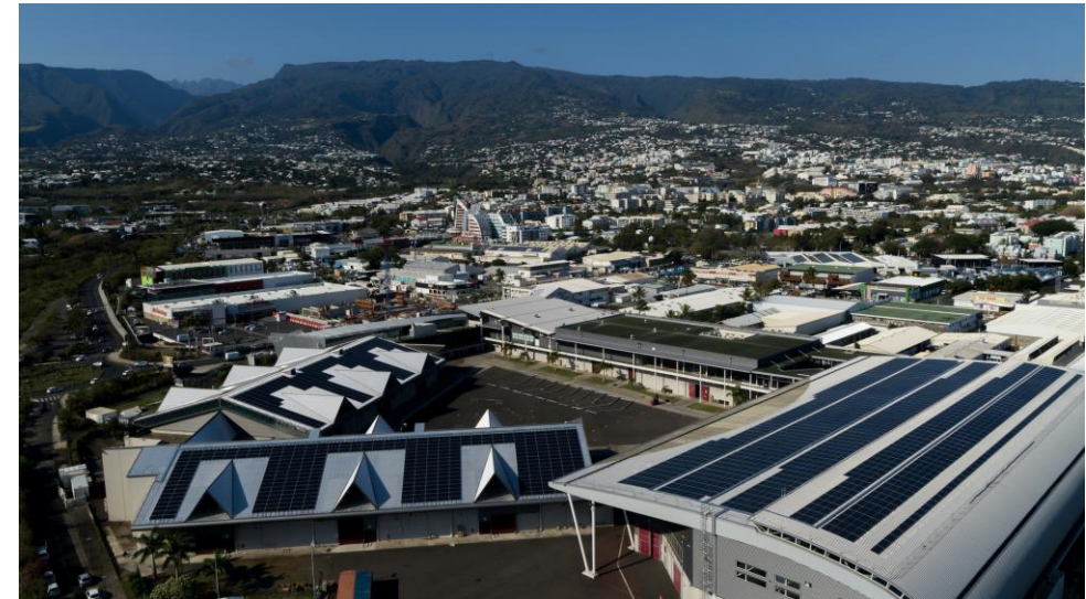
Centrale photovoltaïque du parc des expositions
