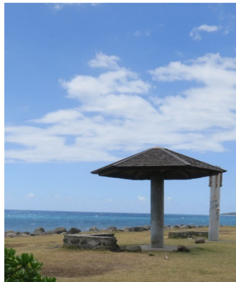
Kiosque sur pilier
